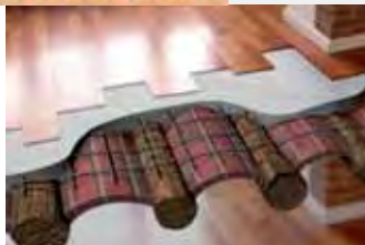
Aplicació de rescrescuts lleugers amb weber.floorlight estructural.
