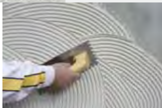
Aplicació del morter cola weber.col flex confort.
