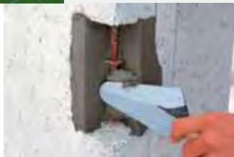
Aplicació de reparador per a formigó.
