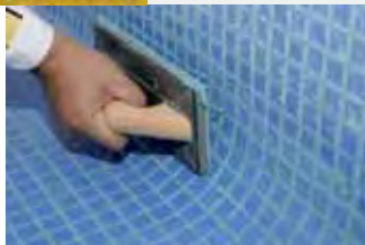
Aplicación del mortero de rejuntado weber. Color premium.
